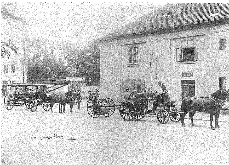
Technika has. sboru v r. 1909. Parní stříkačka, pojízdný naviják a posunovací žebřík 25 m. Vlevo budova Panského mlýna.
