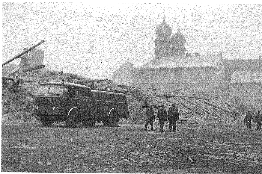
Odstřel "35" kasáren - prosinec 1968.
