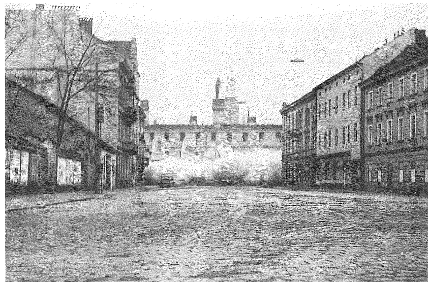
Odstřel "35" kasáren - prosinec 1968.
