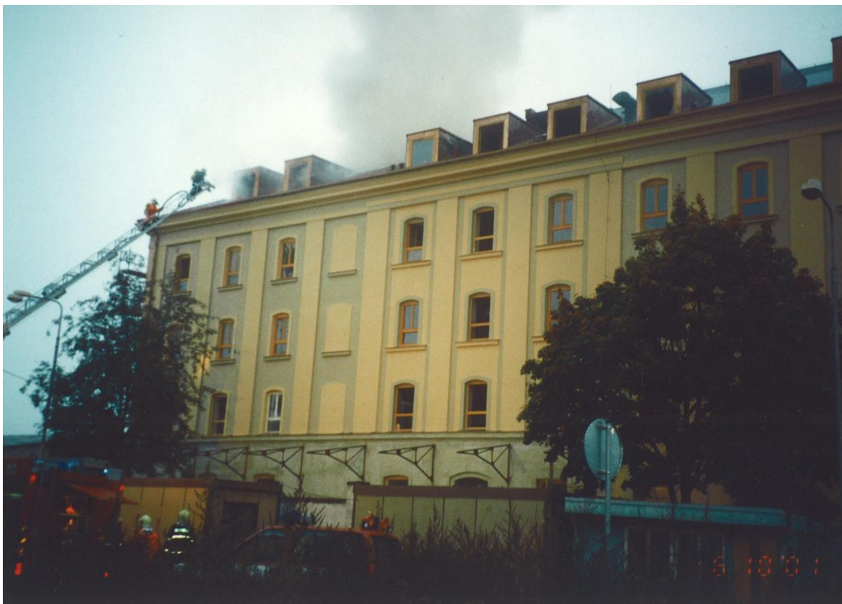
Foto č. 16 - Budova krajského státního zastupitelství při požáru střechy dne 6. 10. 2001
