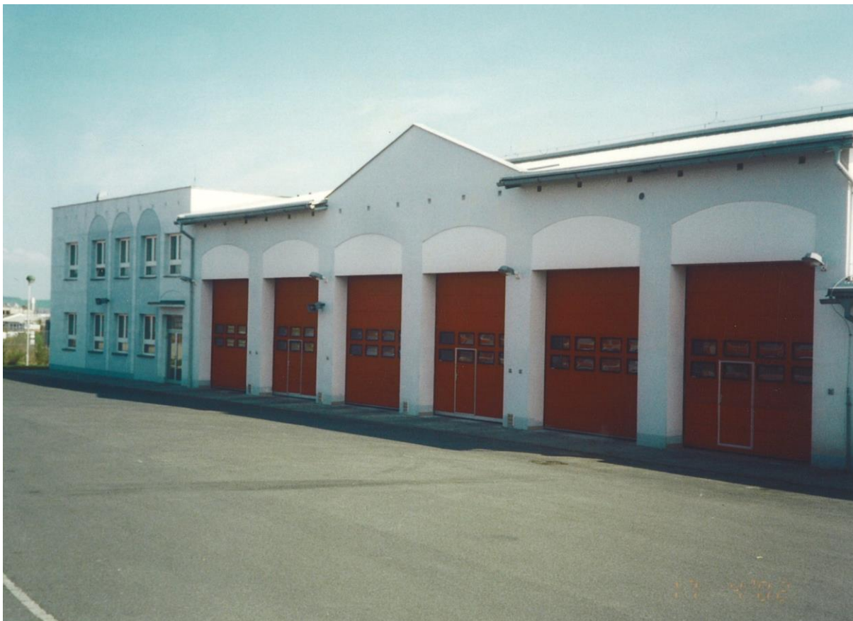
Foto č. 2 – a nyní pohled na nová garážová stání na pobočné stanici v ul. U seřadiště.
