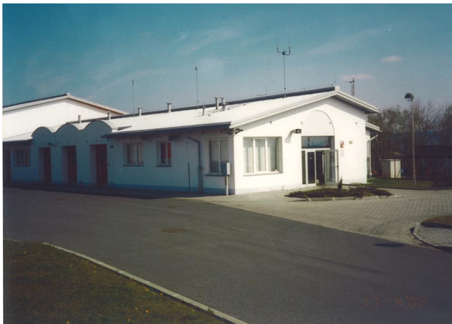
Foto č.3 - Vrátnice pobočné stanice s garážemi pro územní záchrannou službu
